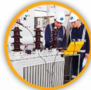
Instalación y Mantenimiento de Transformadores y Estabilizadores
