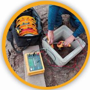
Mantenimiento y Certificación de Pozo a Tierra
